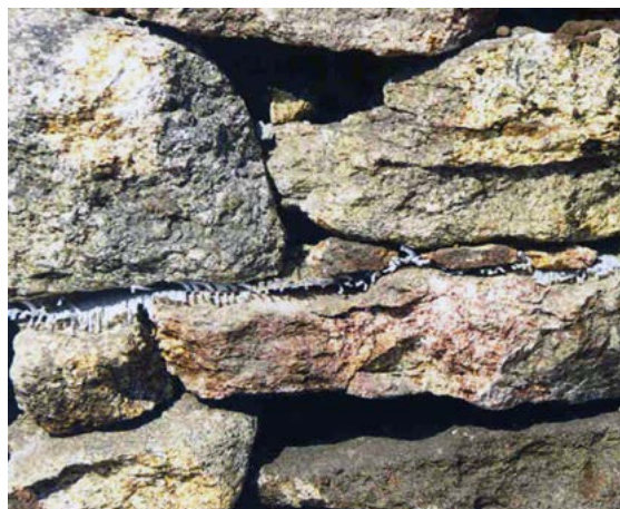
Figura 6. División entre el muro preexistente y la parte reconstituida, mediante fibra de geotextil sintético en una de las estructuras del poblado de Cossourado (Fotografía: Silva, M. de F. M. da 2013). Separation between the preexisting wall and the reconstructed section, made with synthetic geotextile fibre in one of the structures of Cossourado village (Photograph: Silva, M. de F. M. da 2013).
