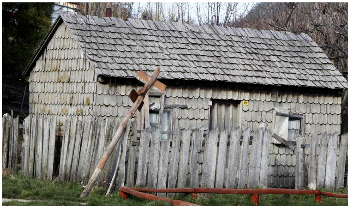
Figura 1. Construcción habitacional en la localidad de Puerto Guadal, con tejuela en techo y tingle (pared), región de Aysén (Fotografía: Castillo, C. 2013).
