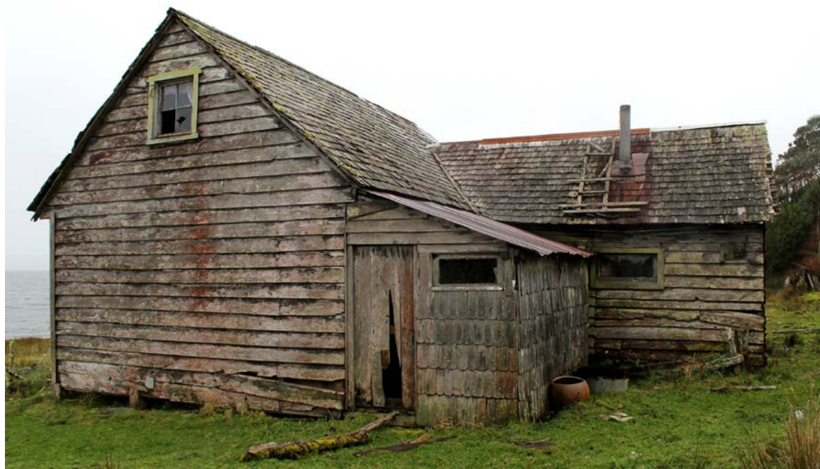
Figura 2. Uso de tejuela en techo y tingle de la ampliación. El resto de los muros han sido revestidos con tablones aserrados. Región de Aysén, sector Repollal medio (Fotografía, Castillo, C. 2013).
