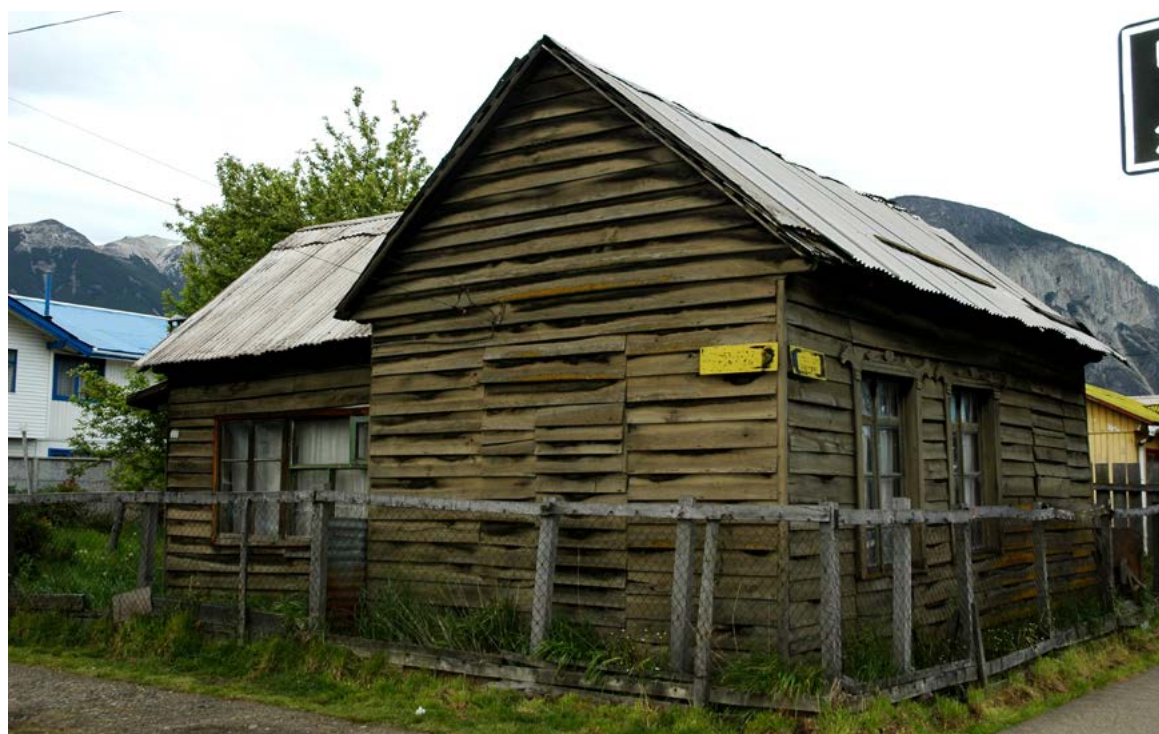
Figura 7. Construcción habitacional en la localidad de Coyhaique, donde la tejuela artesanal del techo ha sido remplazada por planchas de zinc debido a su avanzado deterioro (Fotografía: Castillo, C. 2011).
