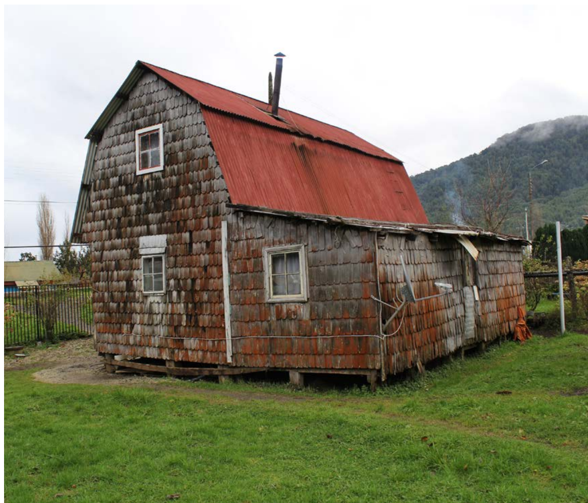
Figura 4. Casa de volumen simple, con techo de dos agua y revestimiento de tejuela en el tingle. Región de Aysén, Puyuhuapi (Fotografía: Castillo, C. 2013).
