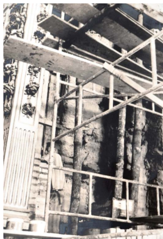
Figura 7. Escoramento da parede de taipa e início das obras de pilastras de tijolos (Fotografia: ACI-RJ, Série CRBC, 1970). Apuntalamiento del muro de tierra y comienzo de las obras de los pilares de ladrillo (Fotografia: ACI-RJ, Serie CRBC, 1970). Shoring of the rammed-earth wall and beginning of the construction of brick pilasters (Photograph: ACI-RJ, CRBC Series, 1970).
